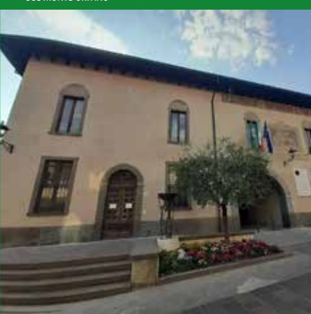
INGRESSO DI PALAZZO MUNICIPALE (1470-1485)
